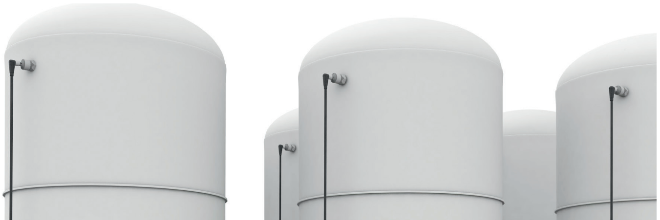
Einbau des kapazitiven Sensors zur Erfassung des maximalen Füllstandes
